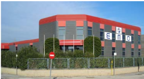
Instalaciones nueva EMO.jpg
